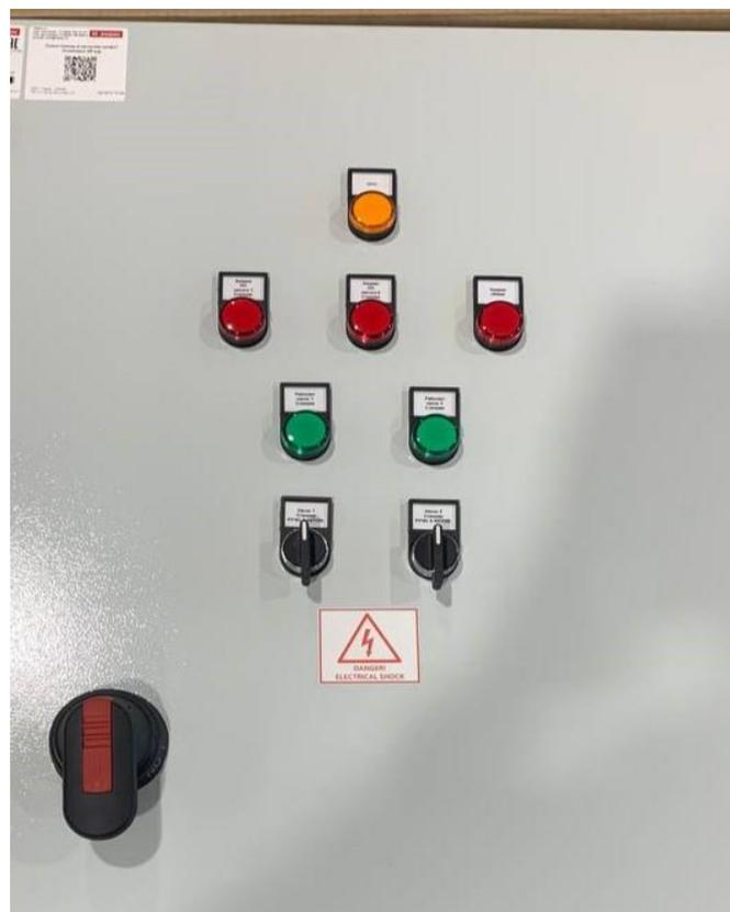
В шкафу располагаются органы управления. ПЛК — специальное управляющее устройство, помогающее автоматизировать технологические процессы. Вводной автомат или выключатель разъединитель (рубильник) предназначен для питания ША. Далее располагается группа автоматов, для внутренних нужд шкафа, питания и защиты цепей
